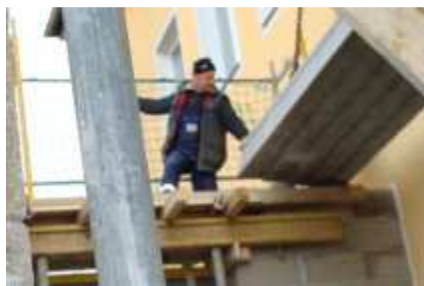
Verlegung der Deckenplatten
